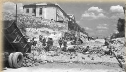
Строительство троллейбусной трассы на Корабельном спуске.
